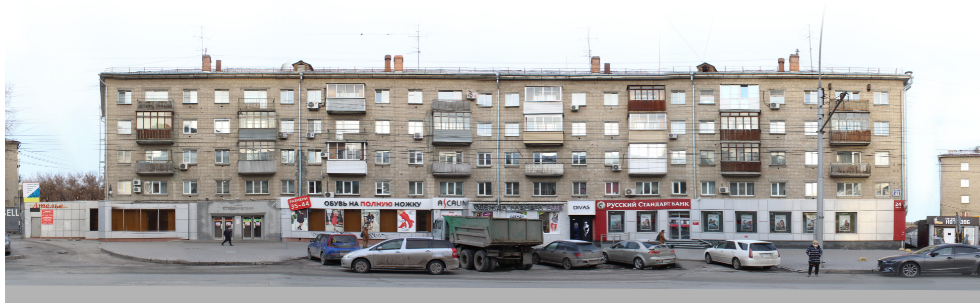
Главный фасад 1-13, выходящий на проспект Карла Маркса
